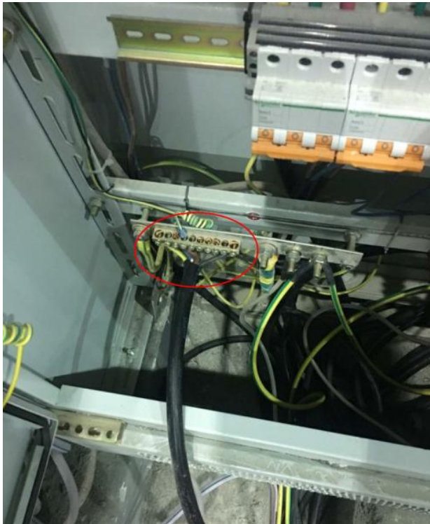
(3) 驱动器进线电缆为非屏蔽电缆
